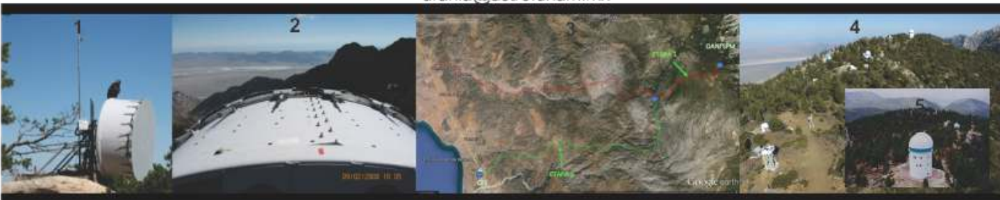
1.- Antena de Radio Del E1, 2.-Antena a su contraparte en la subestación "El dorado Rancho" de Telnor, 3.-Recorrido de instalaciones de la fibra óptica al OAN-SPM hacia Col. Vicente Guerrero, 4.-OAN-SPM, Zona Telescopios 2019, 5.- OAN-SPM Zona telescopios 2005
