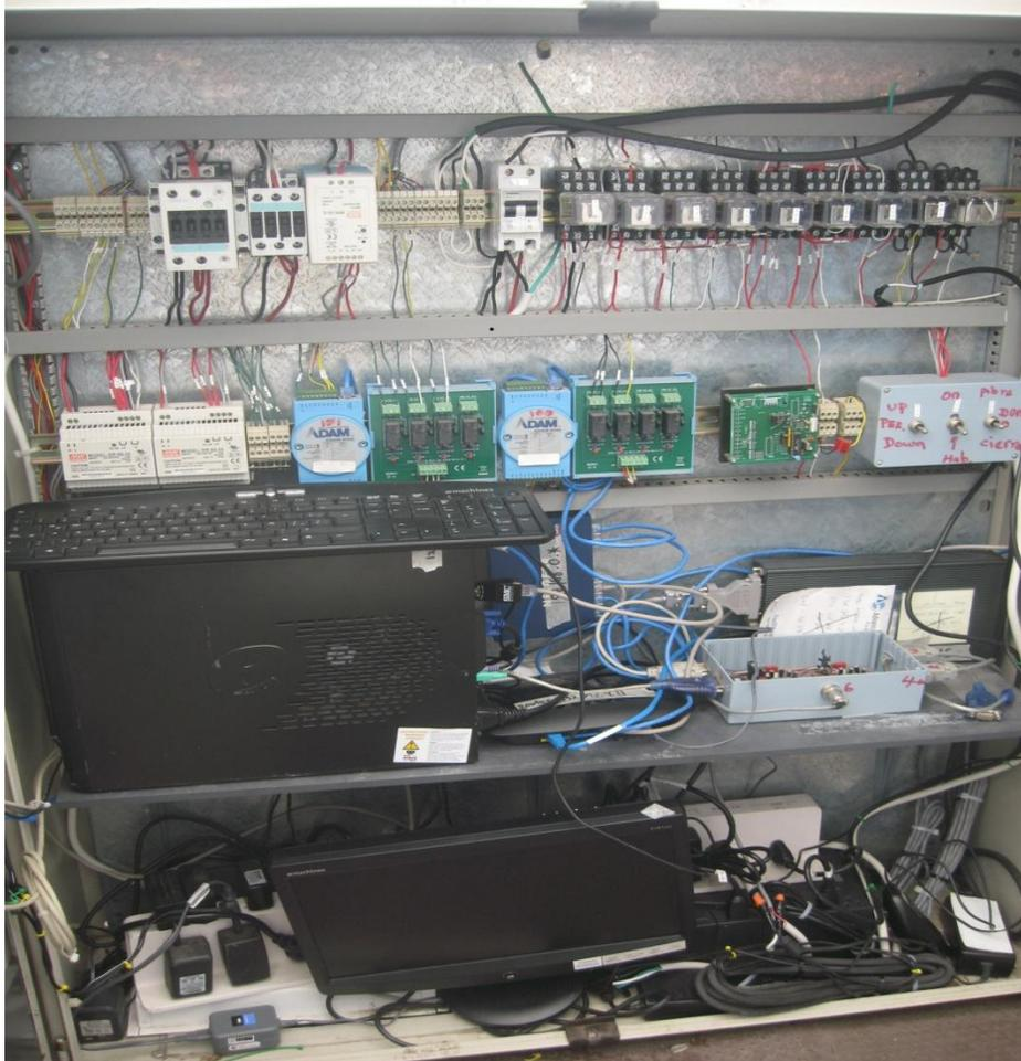
*Figura 6: Imagen del interior del gabinete donde se pueden ver los rieles DIN y los componentes del sistema de control.*
