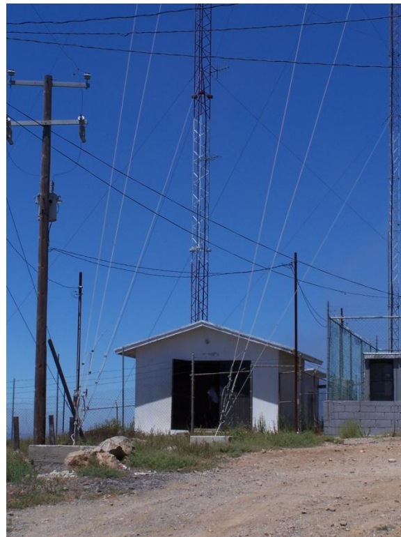
Figura 5: Torre transmisora en el cerro Punta Banda.
