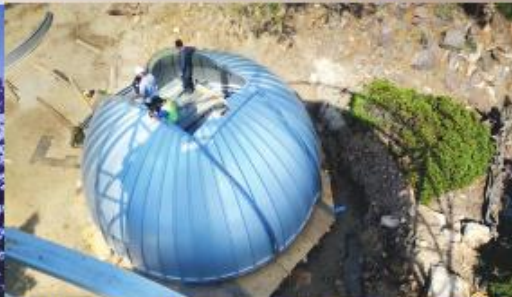
Construcción de los domos del proyecto TAOSII
