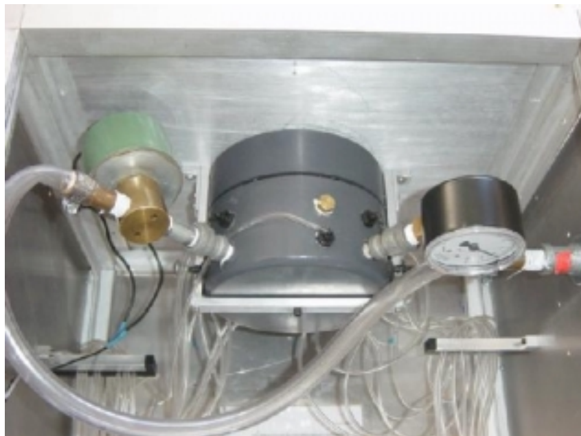
Figura 8. Condensador neumático que distribuye a los reguladores; la electroválvula a la izquierda y el manómetro a la derecha.
