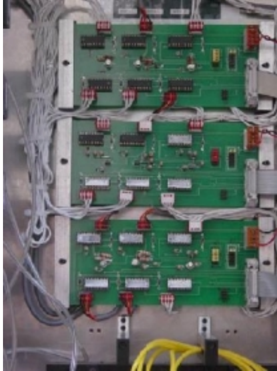
Figura 5. Tarjetas que manejan a 6 reguladores de presión cada una.
