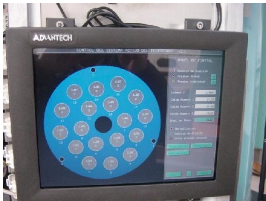
Figura 10. Monitor plano de cristal líquido instalado en el interior de la caja de control.
