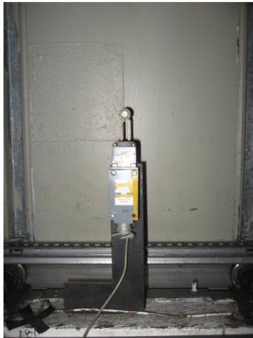
Figura 8: Interruptor que actualiza la posición del domo.
