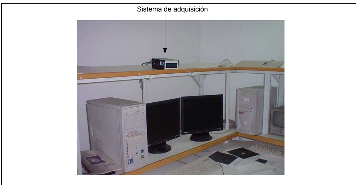
Figura 7. Instalación del sistema de adquisición en el cuarto de observación.
