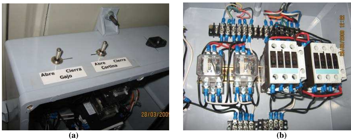
Figura 5. Arrancadores reversibles de los motores.
