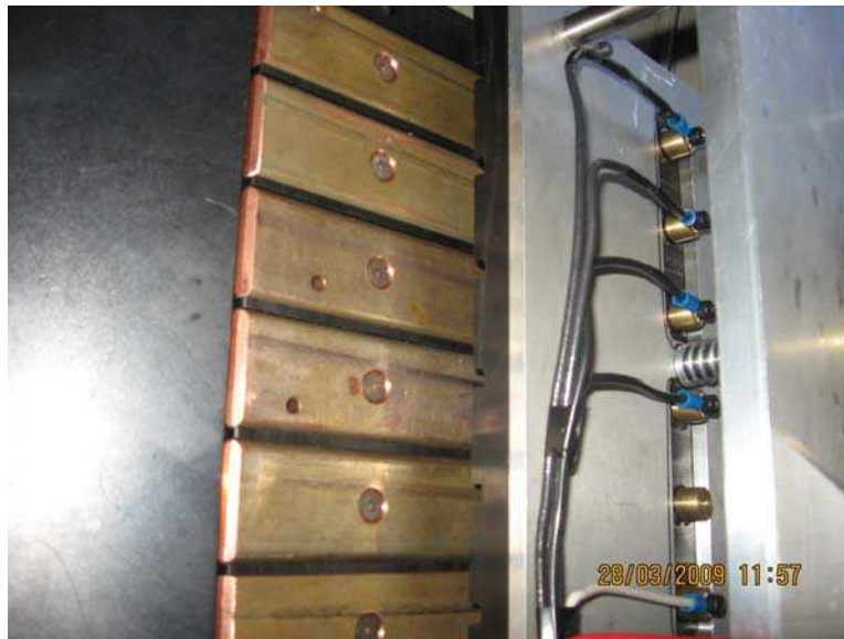
Figura 6. Contactos deslizables de control de cortina/gajo.
