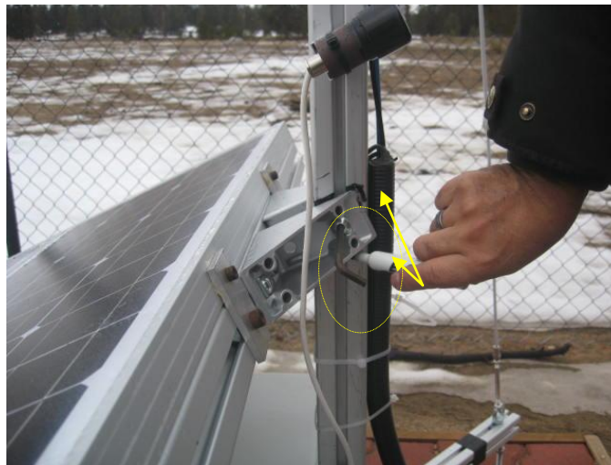
Figura 5: Líneas de referencia para volver a montar paneles.
