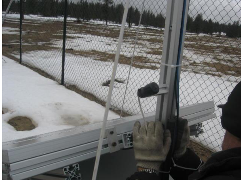
Figura 6: Sujetar paneles solares de la parte superior.
