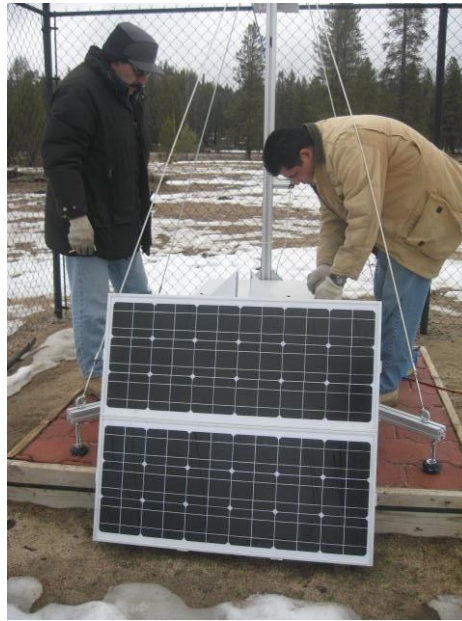
Figura 8: Posición del panel solar una vez desmontado.
