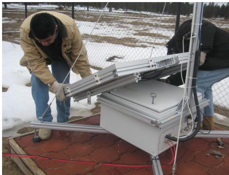
Figura 7: Sujetar paneles solares de la parte inferior.
