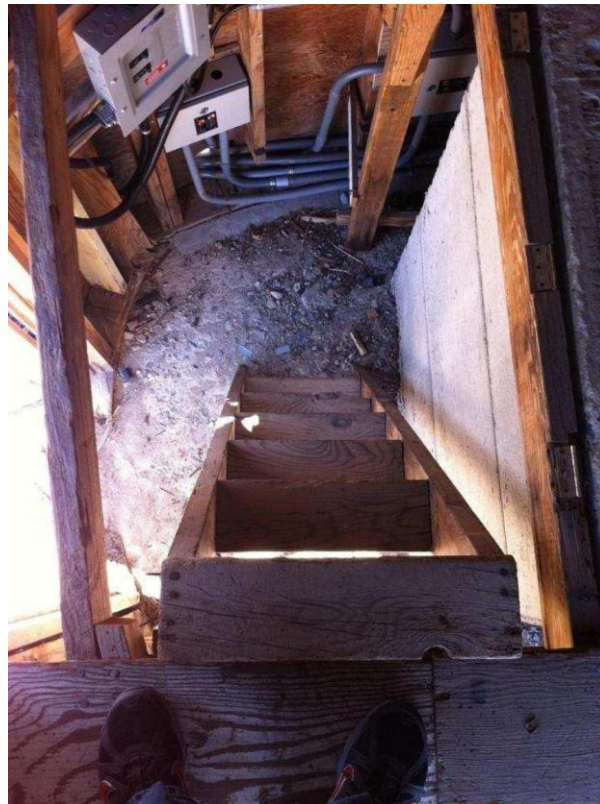
Figura 5: Vista superior de la escalera de acceso a la plataforma de observación. A la derecha se ve una parte del pilar.
