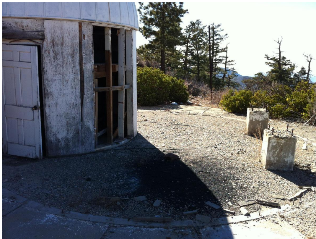
Figura 2: Vista de los cimientos circulares del antiguo edificio del SPM84. A la derecha, los restos de los dos cubos de cemento armado donde se apoyaban las patas Norte de dicho telescopio.
