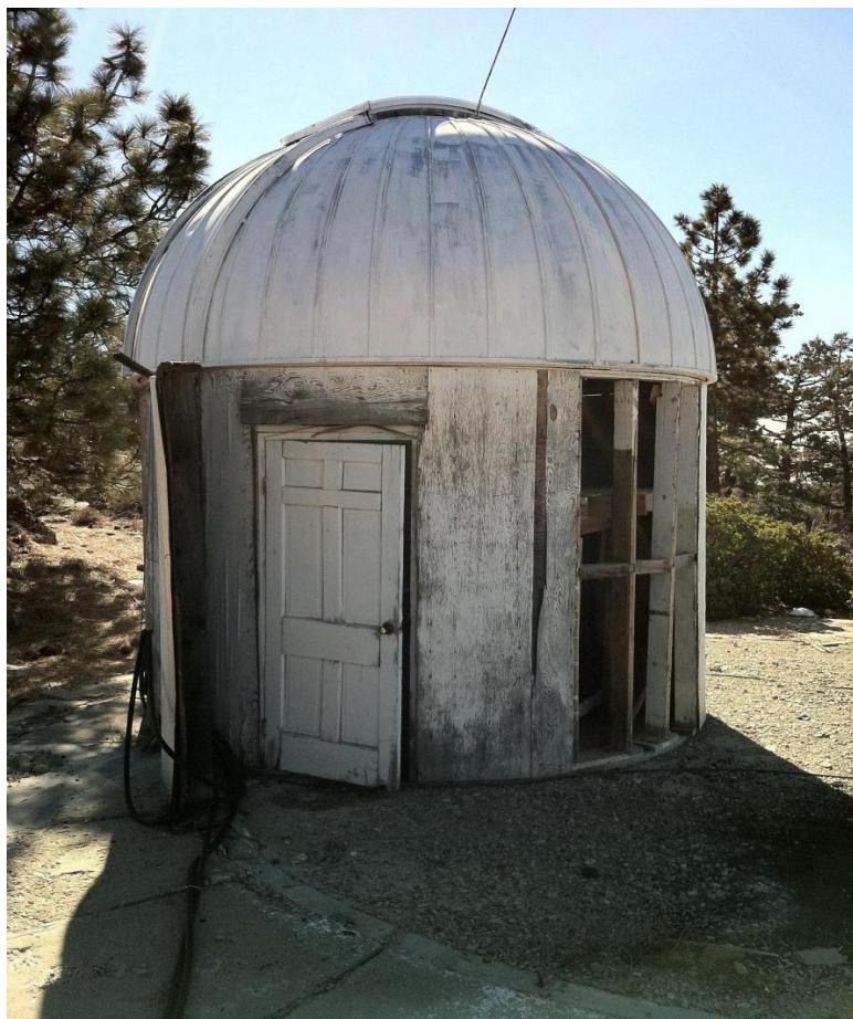
Figura 1: Vista de la edificación desde el Noreste.
