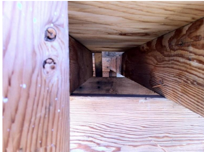
Figura 7: Estructura de soporte de la Plataforma de Observación.
