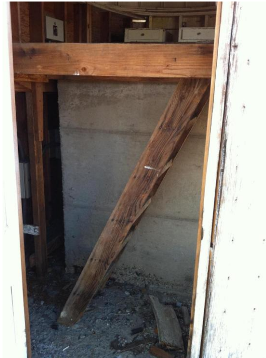
Figura 4: Vista de la escalera de acceso a la plataforma de observación. Al fondo, el pilar.
